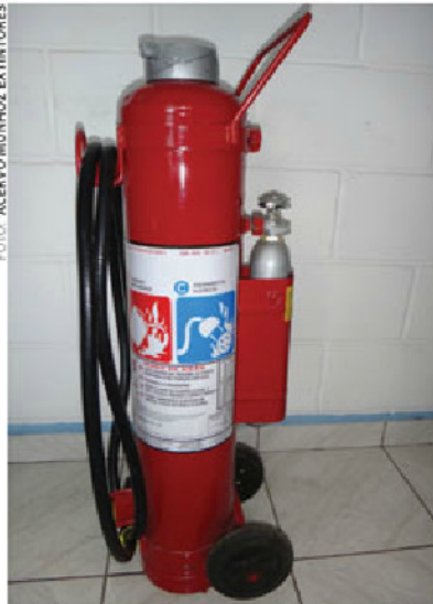
Extintor sobre rodas com carga de pó BC de 20 quilos, com pressurização indireta
