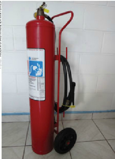
Extintor sobre rodas com carga de pó BC de 20 quilos, com pressurização direta
