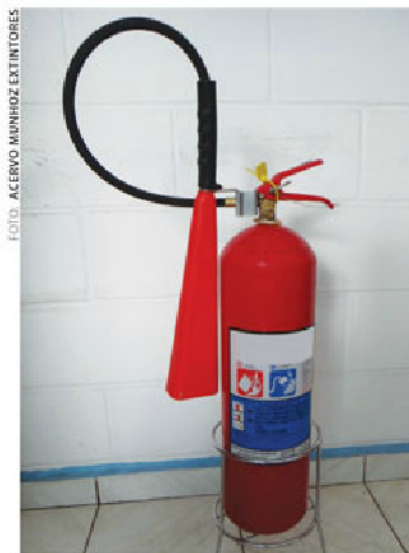
Extintor de incêndio com dióxido de carbono de 6 quilos
