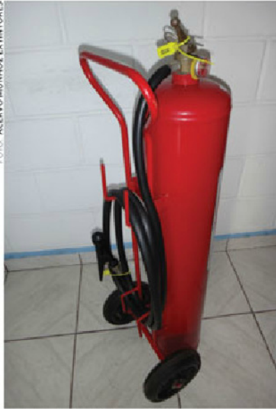
Extintor de incêndio sobre rodas
