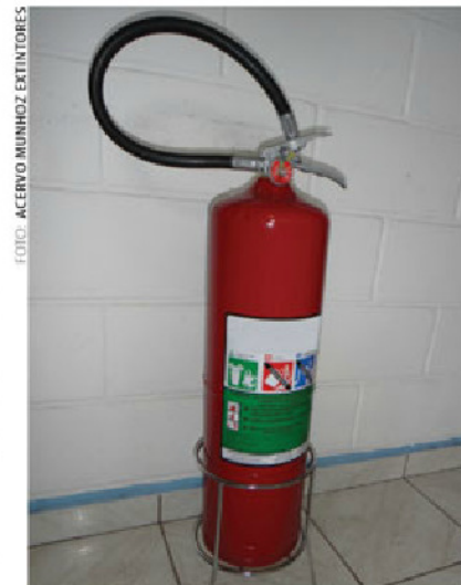
Extintor de incêndio pressurizado com carga de água de 10 litros
