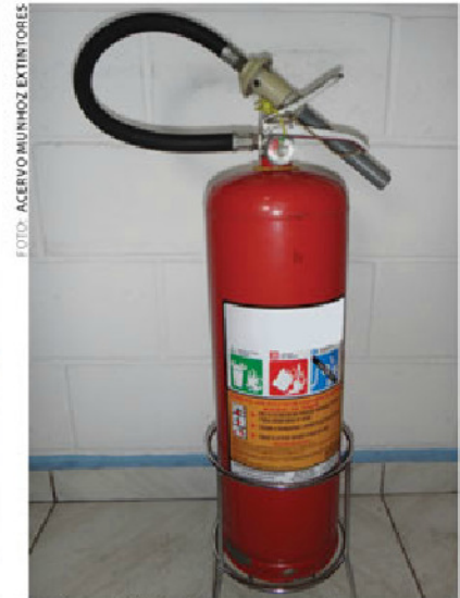
Extintor de incêndio com carga de espuma mecânica de 10 litros
